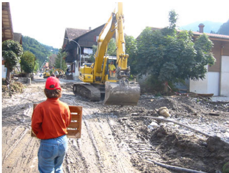
Abb. 5-5: Die Aufräumarbeiten sind im vollen Gange
